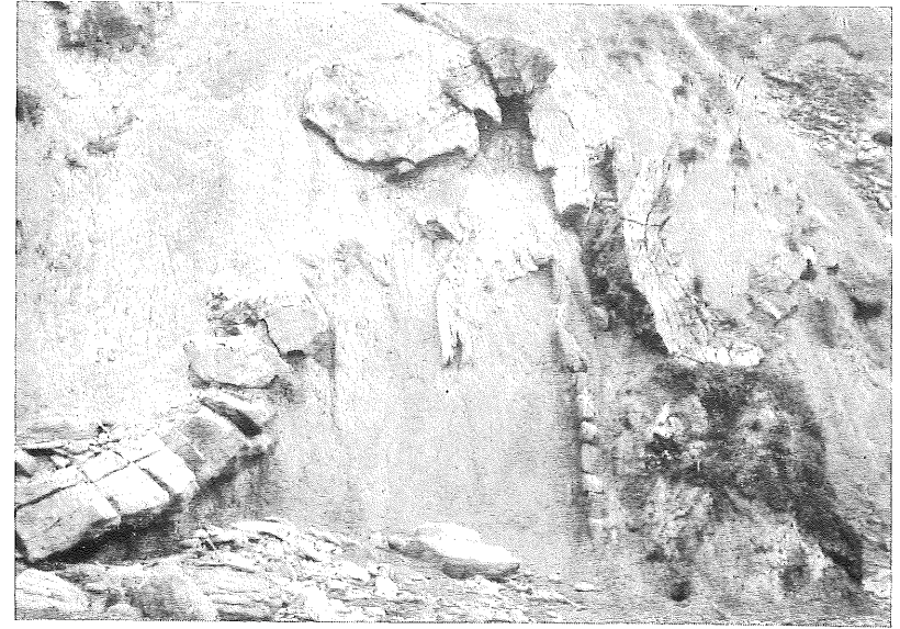
Fig. 3.—Cala Boquer. Detalles del plegamiento en los bancos de areniscas intercaladas en los depósitos margosos, Burdigaliense.
